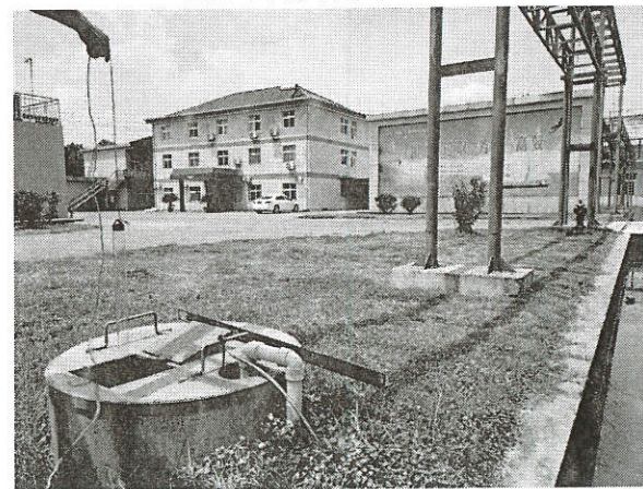
地下水监测井（☆1#）
