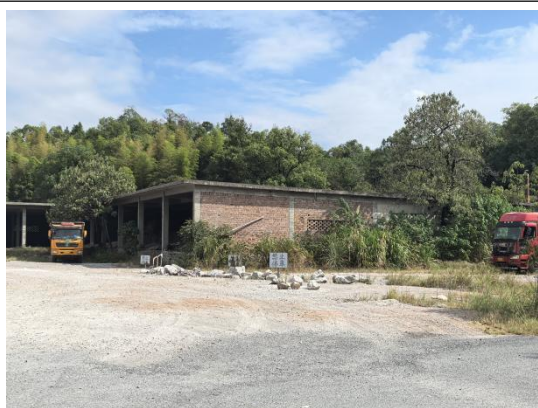
金顶水泥厂库房
